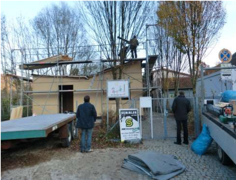
Hier entsteht die neue Kinderkrippe beim Kindergarten St. Johannes
