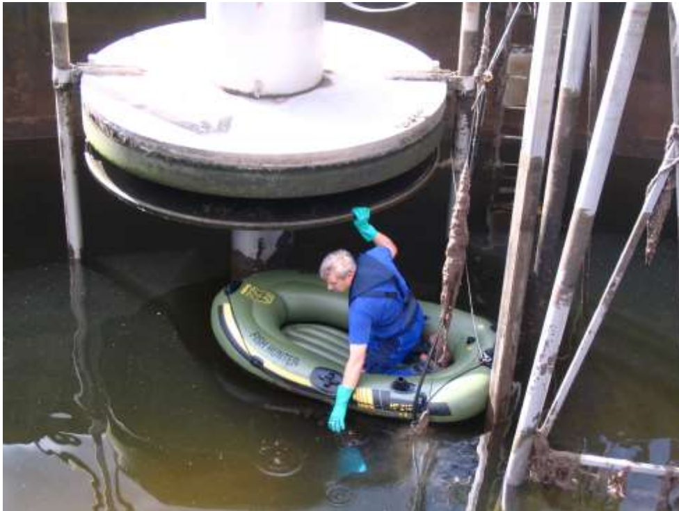
Wartungsarbeiten in einem Abwasserreaktor
