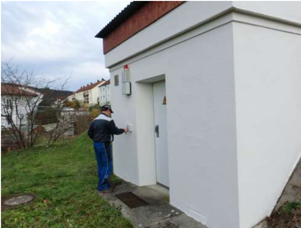
Pumpanlage an der Bergstraße – wieder fast wie neu
