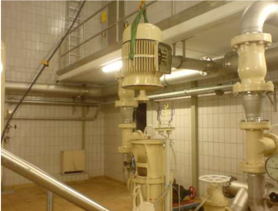
Pumpensanierung im Wasserwerk
