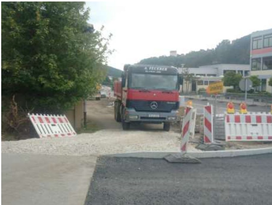
Der Ausbau der Schulstraße erfolgte innerhalb eines engen Zeitfensters
