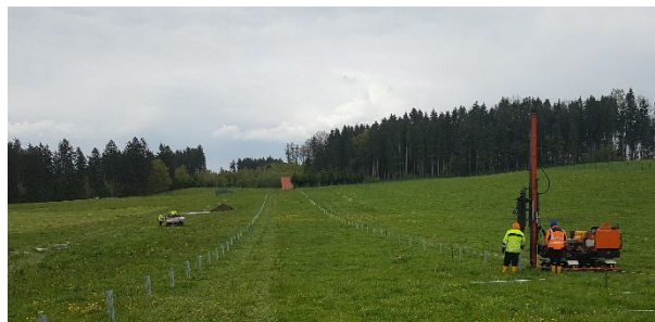
Abbildung 2: Hydraulikramme auf Ketten
