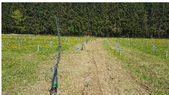
Abbildung 3: Verfüllter Kabelgraben
