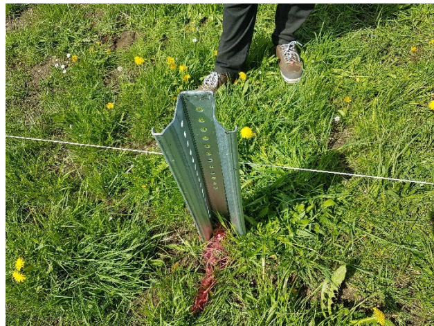
Abbildung 5: Rammfundament
